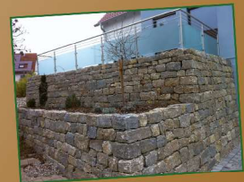
Gabionen und Mauern
