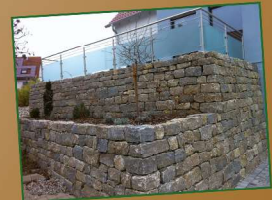
Gabionen und Mauern
