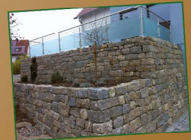
Gabionen und Mauern
