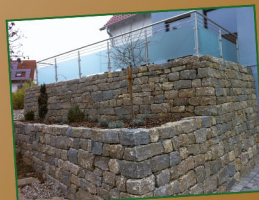
Gabionen und Mauern
