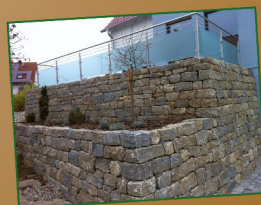
Gabionen und Mauern
