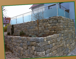
Gabionen und Mauern
