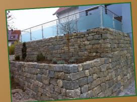
Gabionen und Mauern
