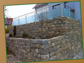
Gabionen und Mauern
