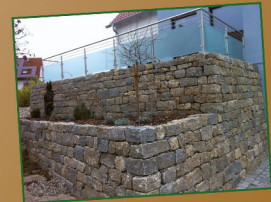
Gabionen und Mauern
