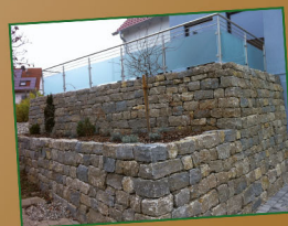
Gabionen und Mauern
