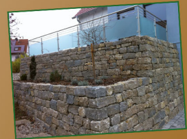
Gabionen und Mauern
