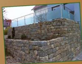
Gabionen und Mauern
