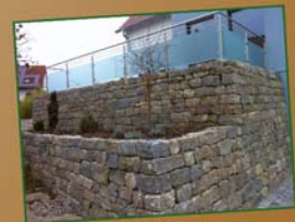
Gabionen und Mauern
