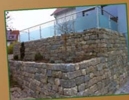
Gabionen und Mauern
