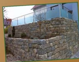
Gabionen und Mauern
