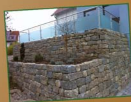
Gabionen und Mauern
