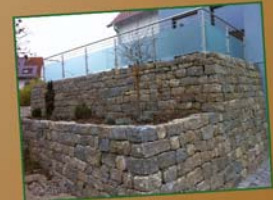
Gabionen und Mauern
