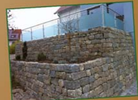
Gabionen und Mauern
