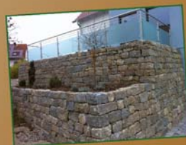
Gabionen und Mauern
