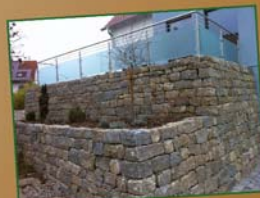
Gabionen und Mauern
