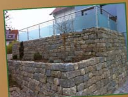
Gabionen und Mauern
