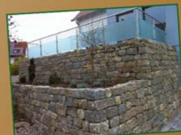
Gabionen und Mauern
