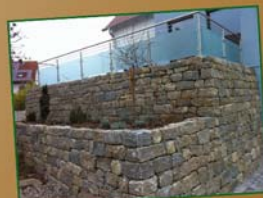
Gabionen und Mauern
