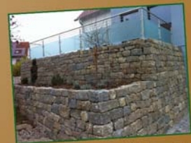
Gabionen und Mauern
