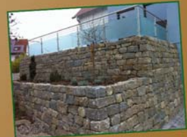
Gabionen und Mauern
